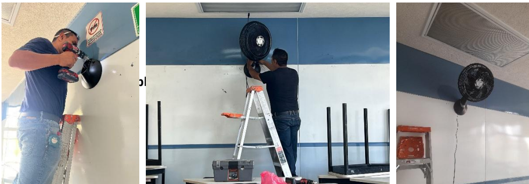
Fotografía 11. Colocación de ventiladores
