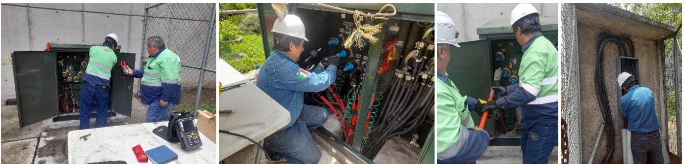
Fotografía 19. Mantenimiento a transformadores
