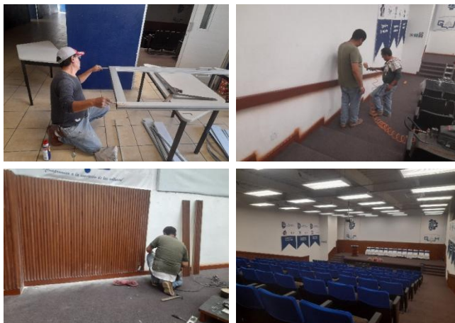
Fotografía 31. Mantenimiento al auditorio del plantel.
