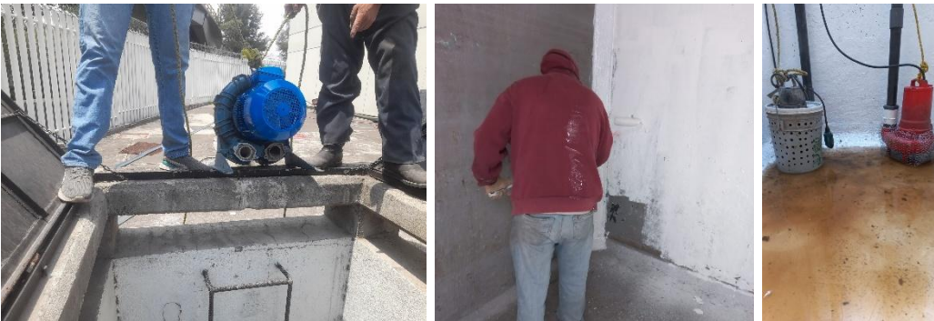
Fotografía 18. Mantenimiento a planta tratadora de aguas residuales
