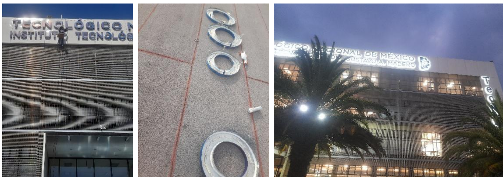
Fotografía 13. Reparación de letras institucionales
