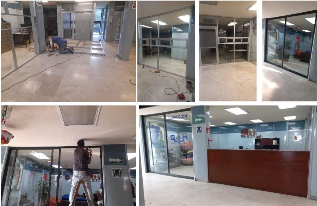
Fotografía 16. Colocación de cancel en el edificio 1
