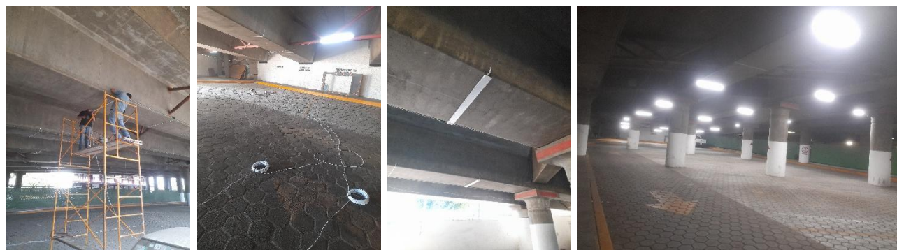
Fotografía 14. Reparación de alumbrado en estacionamiento.
